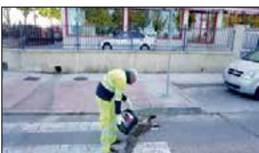
Operarios realizando trabajos de parcheo de asfalto.
