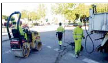
Operarios realizando trabajos de parcheo de asfalto.
