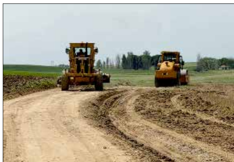
Las labores de acondicionamiento incluyen el perfilado de cunetas, el rasanteo de las superficies y el aporte de materiales en los tramos más deteriorados por el uso y las inclemencias meteorológicas.
